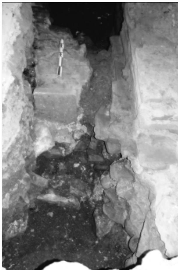
FIG. 12. VUE D'UNE MAÇONNERIE DISJOINTE ET D'UN PUIT MÉDIÉVAL, le long du mur arrière de l'église Saint-Pierre-Saint-Géraud. Cliché J.-L. Boudartchouk/INRAP.
